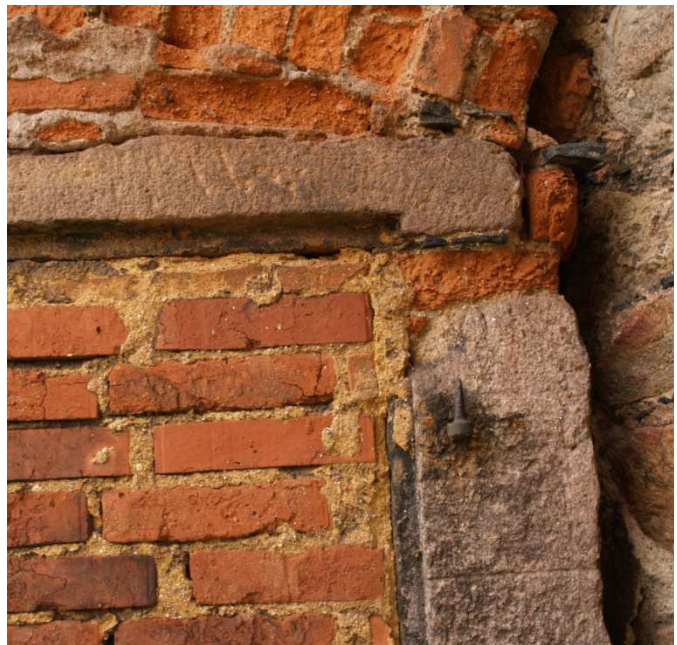
Zazděná porta, západní průčelí Detail osazení
