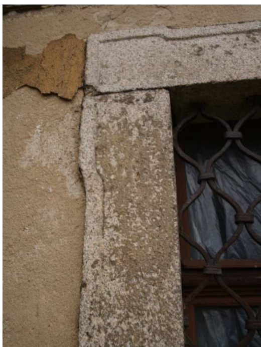
Severní průčelí , okno sakristie Det. Zbytky mladší maltoviny;; Parapet , černá krusta
