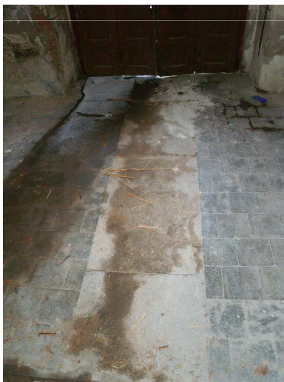
Dlažební kamenný pás spojující porty severní předsíně a lodě kostela
